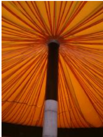
Abbildung 7: Innenmembran mit Kunststoffnetz zur Ansiedelung der Thiobakterien zur Entschwefelung des Biogases
